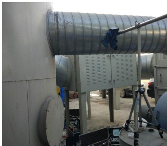
1#有组织废气处理前进气口 B
